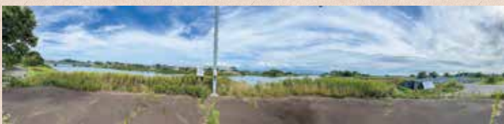
浦ノ入橋～新発田川上流～内島見橋～浦ノ入水門へのパノラマ合成写真
