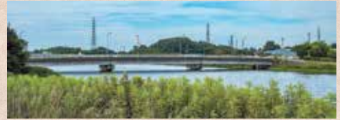
浦ノ入橋と東港ガントリークレーン
